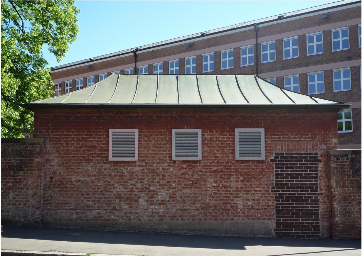
Den Übergang zum dritten Flügel markiert ein vorspringender Erker möglicherweise mit einem Treppenhaus im Inneren. In der Mauer eine ehemalige Tür. Einige Ziegelsteine der Außenmauer zeigen bereits Spuren von Wind und Wetter, obwohl sie oben Steinplatten schützten.
